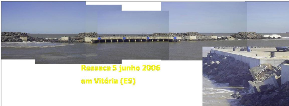
Figura 45. Colapso do enrocamento do molhe de abrigo do Terminal de Barcaças da Siderúrgica de Tubarão em junho de 2006.
